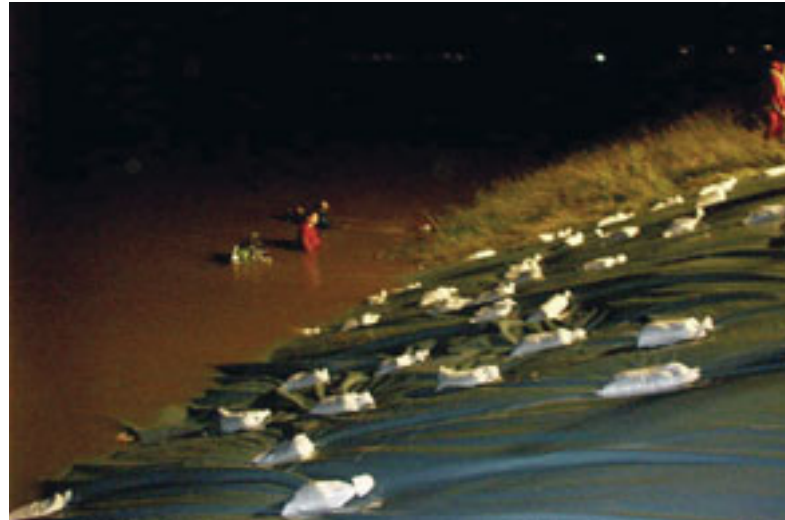
Taucher beim Auslegen von Folie und Sandsäcken
