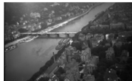
Friedrichsbrücke – davor die „neue“ Blum'sche Badeanstalt
