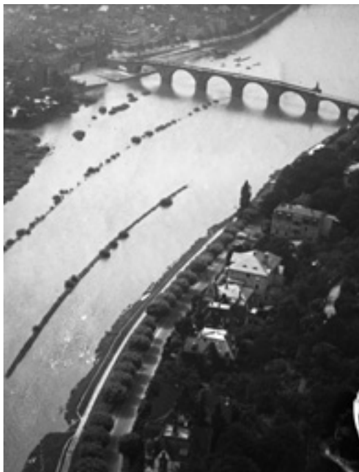
Hackteufel und Alte Brücke vor der Kanalisierung
